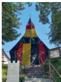
Die Kapelle im Zustand der Begasung zur Bekämpfung des Holzwurmes.
