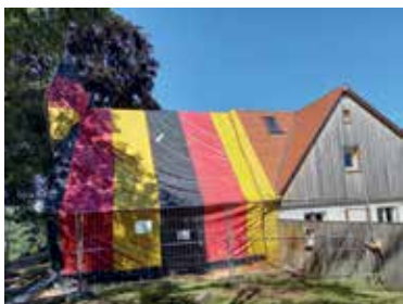
Die Kapelle im Zustand der Begasung zur Bekämpfung des Holzwurmes.
