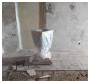
Die Kapelle im Zustand der Begasung zur Bekämpfung des Holzwurmes.
